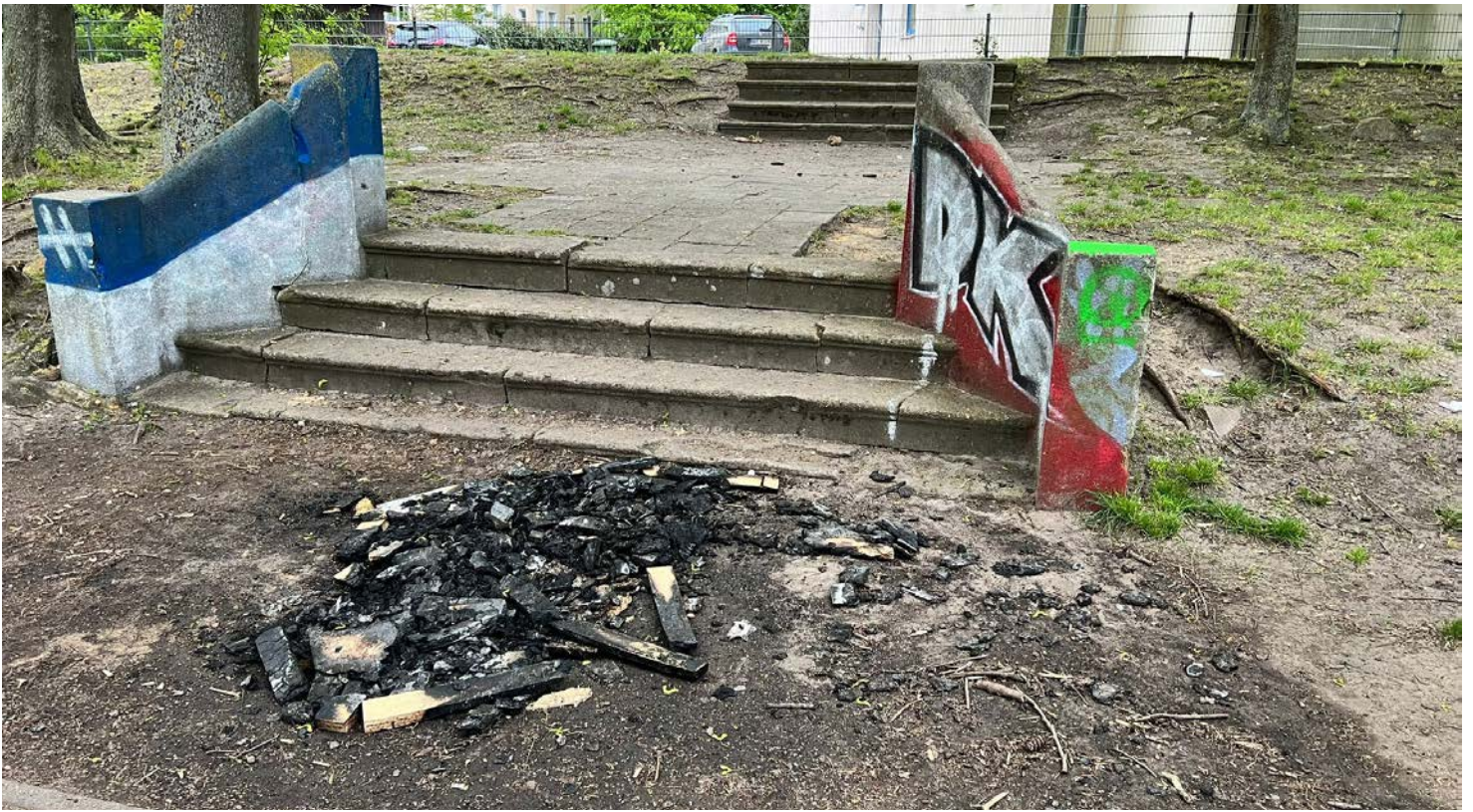
Deutlich zu sehen ist die offene, ungesicherte Feuerstelle. Fotoquelle: Gemeinde Wandlitz
