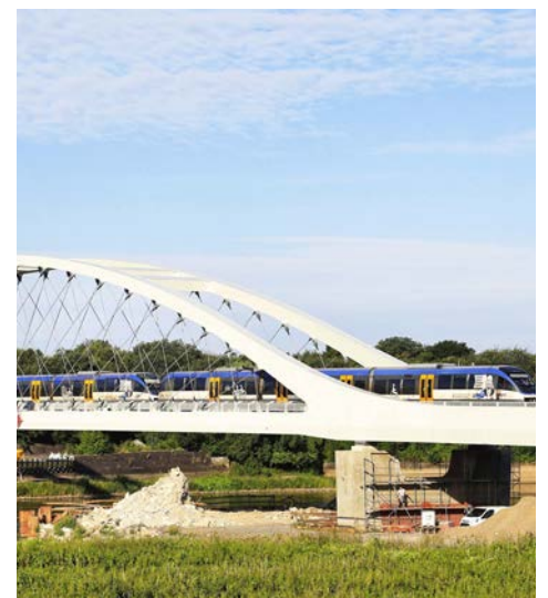
Foto eines Zuges der RB26 auf der neuen Brücke über die Oder. Foto: © NEB/S.Bohne
